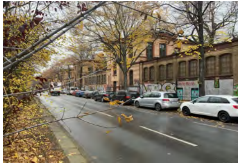
(a) Pavillons Urban-Krankenhaus (Berlin)
