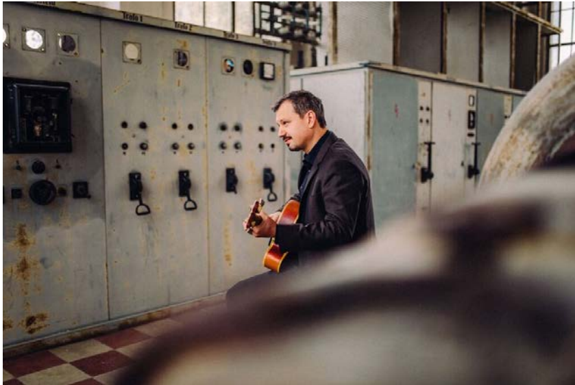
Andreas Dombert in der Kraftzentrale Straubing, in der „Minimal Music“ aufgenommen wurde. Foto: Michael Schöllhorn
