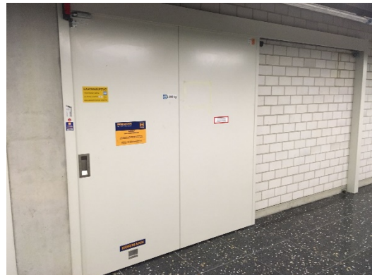
Brandschutztor geschlossen
